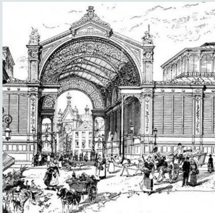
Centrale Hallen voor de aanleg van Parking 58. Foto: alob46.wordpress.com
